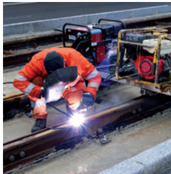
Schweißarbeiten am Gleiskörper.
