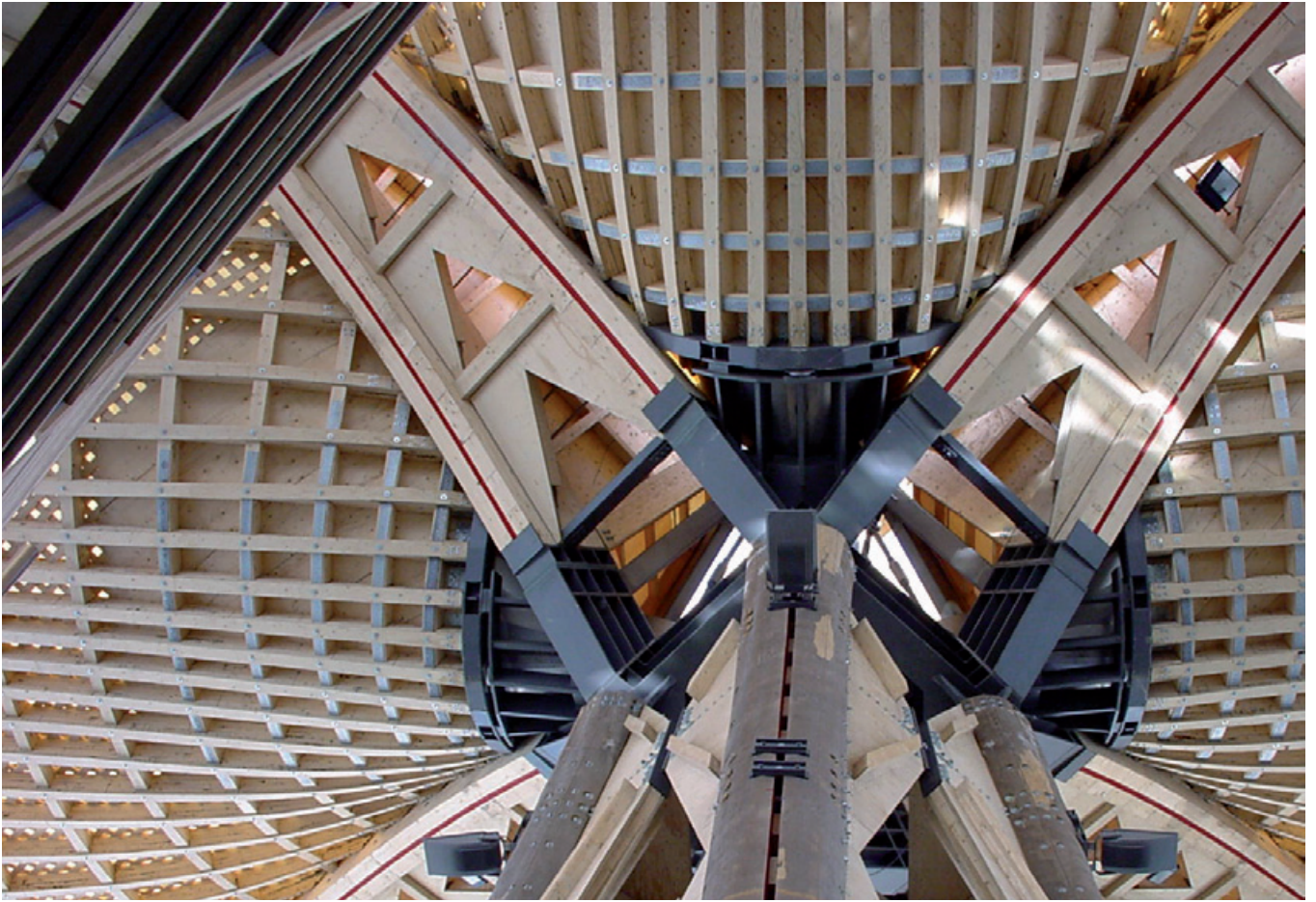
Dachkonstruktion auf der Expo- Weltausstellung 2000 in Hannover.
