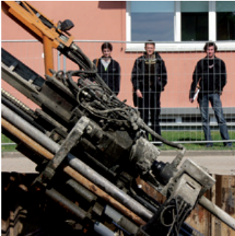
Besichtigung einer Ankermaschine: Ergänzung der Vorlesung Spezialtiefbau.
