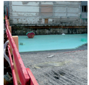
Wärmedämmung einer Kellerbodenplatte.
