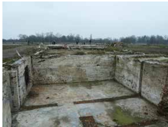
Abbildung 4: Entwurfsteilnehmer auf dem Gelände des ehemaligen Außenlagers bei Gablingen.
