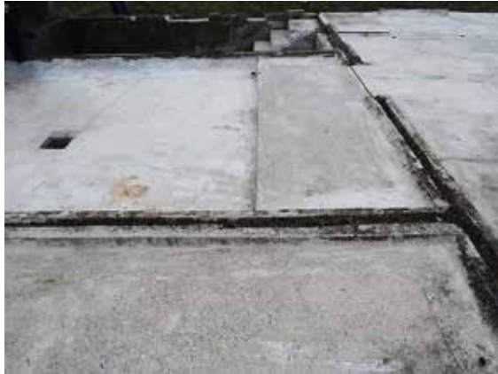
Abbildung 5: An den Ruinen der ehemaligen Lagergebäude lassen sich Nutzung und frühere Baukonstruktion noch ablesen.
