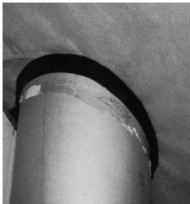
Bild 10: Abdichtung einer Rohrdurchdringung mit einem Butylkautschuk-Dichtungsband
