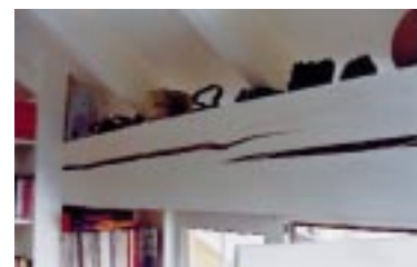
Bild 8: Großer Riss: optischer Mangel, aber keine Beeinträchtigung der Tragfähigkeit
