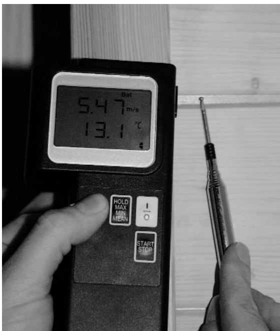
Bild 14: Gemessene Luftgeschwindigkeit von 5,47 m/s im Bereich einer undichten Nut-Feder-Schalung
