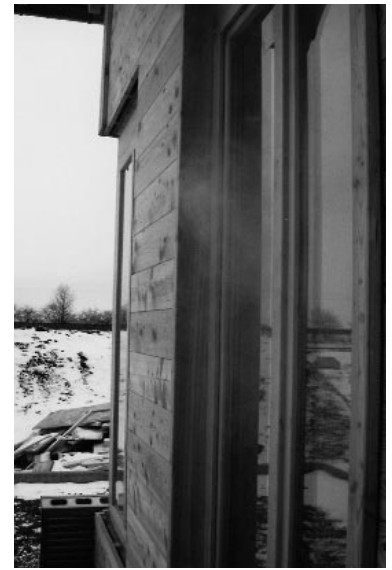
Bild 13: Austritt von Rauch (Nebel) aus Türanschluss
