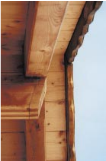
Bild 4: Angestückelte First- pfette
