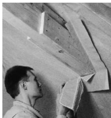
Bilder 11: Luftdichte Balkendurchdringung unter Verwendung von Manschetten
