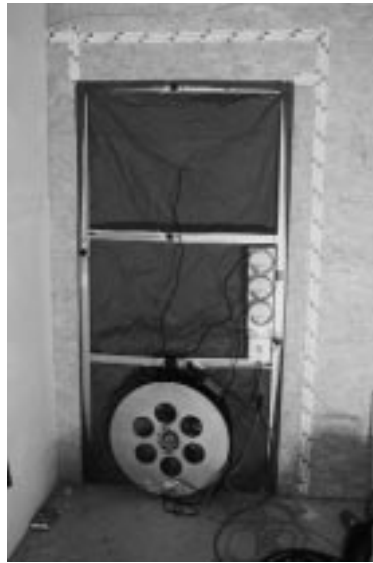
Bild 12: Blower-door-Prüfung: in Türrahmen eingepasster Ventilator mit Messuhren
