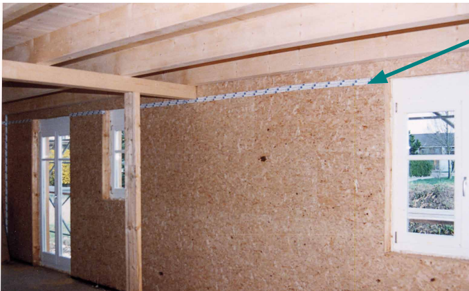
Abb. 6: Unzulässiger nicht unterstützter (= freier) Plattenstoß in Wänden
