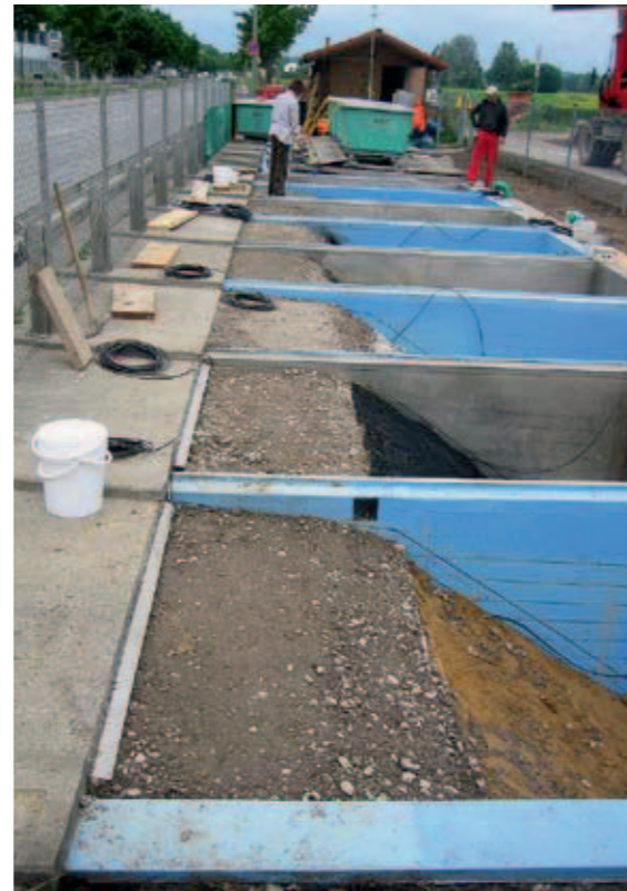
Abb. 2: Lysimeteranlage mit frisch angelegten Böschungen, hier noch ohne Andeckung mit Oberboden und Bewuchs (Foto: BAST, Juni 2010).
