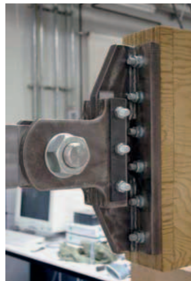
Abb. 5a: Gewindestangenpaket mit Stahlanschluss.
