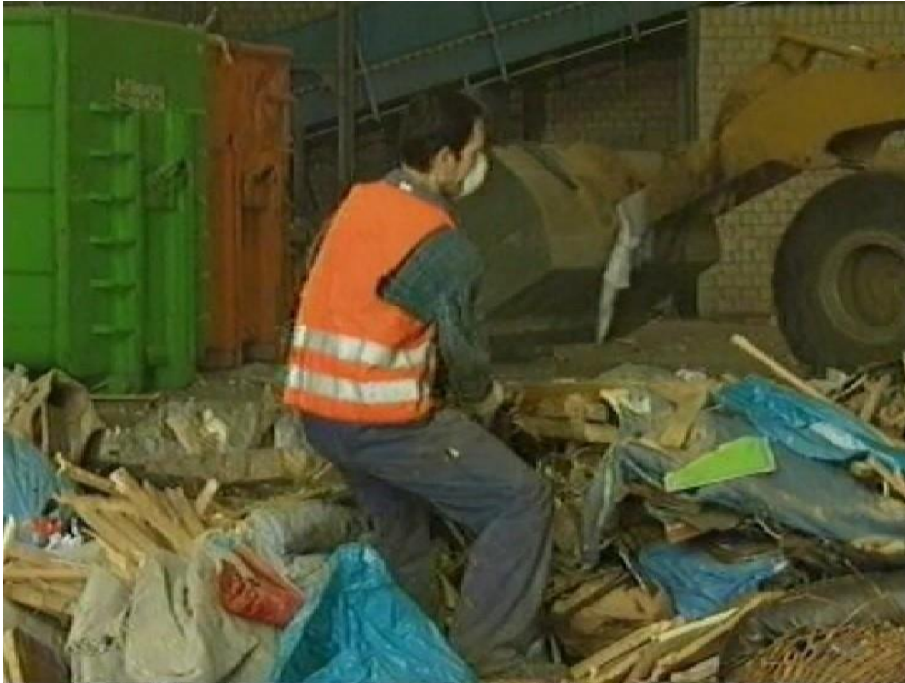
Bild1: Arbeiter beim Herausziehen von „Störstoffen“
