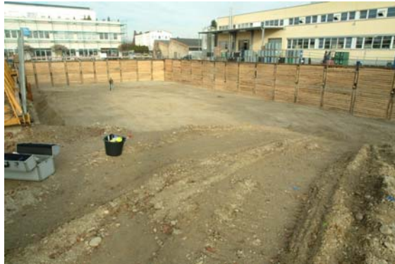
Foto Baugrube Neusäß
