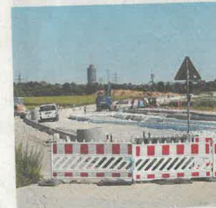
In Richtung Messe (Hotelturm im Hintergrund) führt diese neue Straße.
