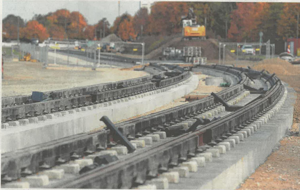
Der Bau der Straßenbahnlinie 3 zwischen Haunstetten und Königsbrunn hinkt im Zeitplan etwas hinterher: Gründe dafür sind Lieferverzögerungen und die Corona-Pandemie, heißt es. Im Dezember 2021 soll die Linie in Betrieb gehen. Foto: Marcus Merk
