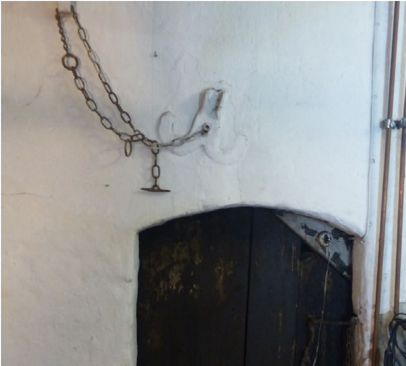
Befund 0.02h_01: Stahlklammer
