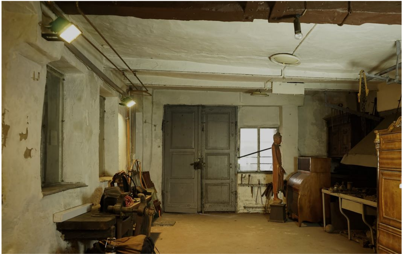
Innenansicht, Blick von Raum 0.02 zu Wand a und Wand b
