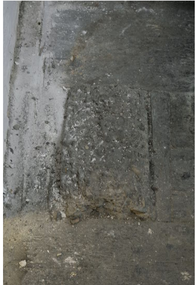
Boden 0.02 Abgeschlagener Betonsockel
