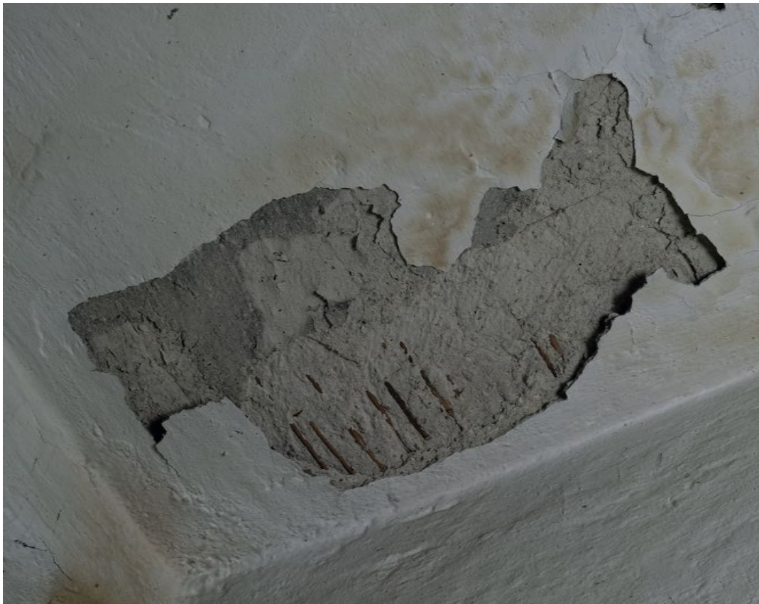
Decke 0.02 süd Schilfrohmatten als Putzträger
