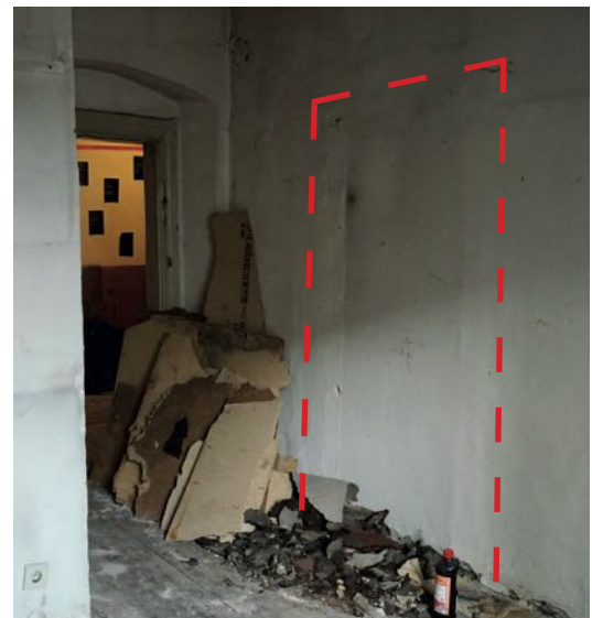
Detailaufnahme Wand 1.06 a Befund 1
