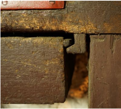
links und rechts: Detailaufnahme Werkbank, Aufhängung Schubladen und Verbindung Mittelpfosten mit Werkplatte
