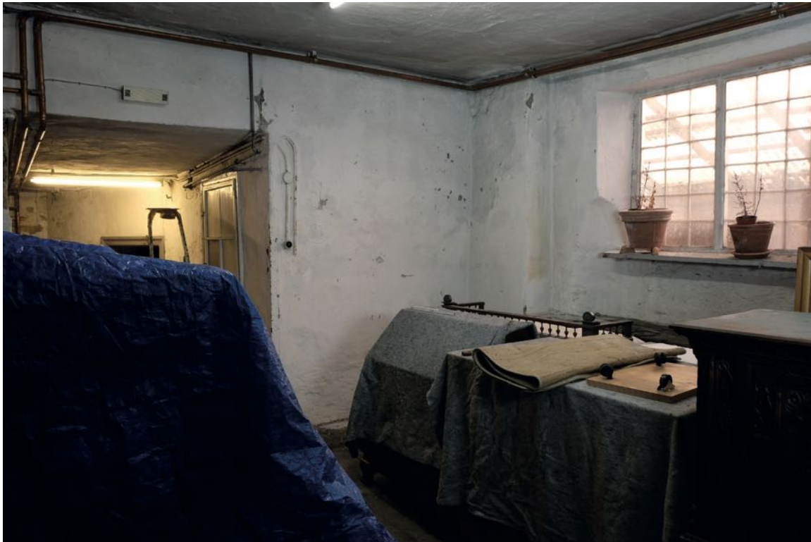
Blick von 0.02 west auf Wände 0.02d und 0.02e
