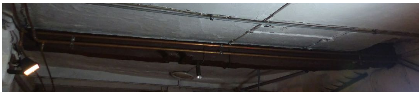
Befund D0.02_01: Unterzug I
