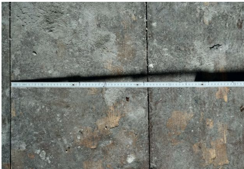
Detailaufnahme Boden, Breite der Holzdielen
