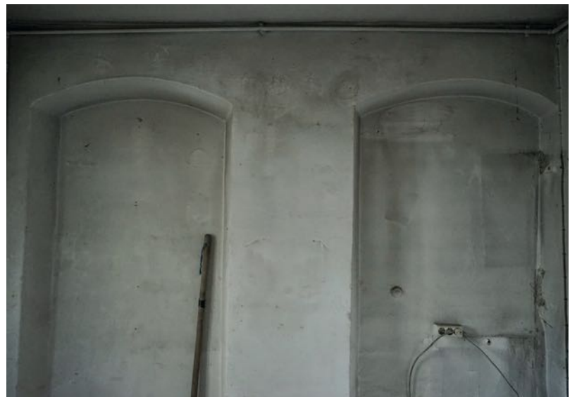
Detailaufnahme Wand 1.06 c, Sparmauerwerk mit Segmentbögen
