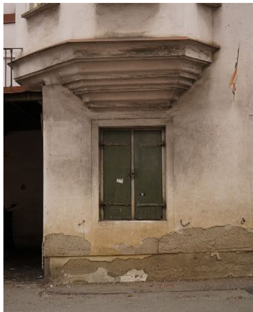
links: Aussenansicht Holzfenster geschlossener Fensterladen
