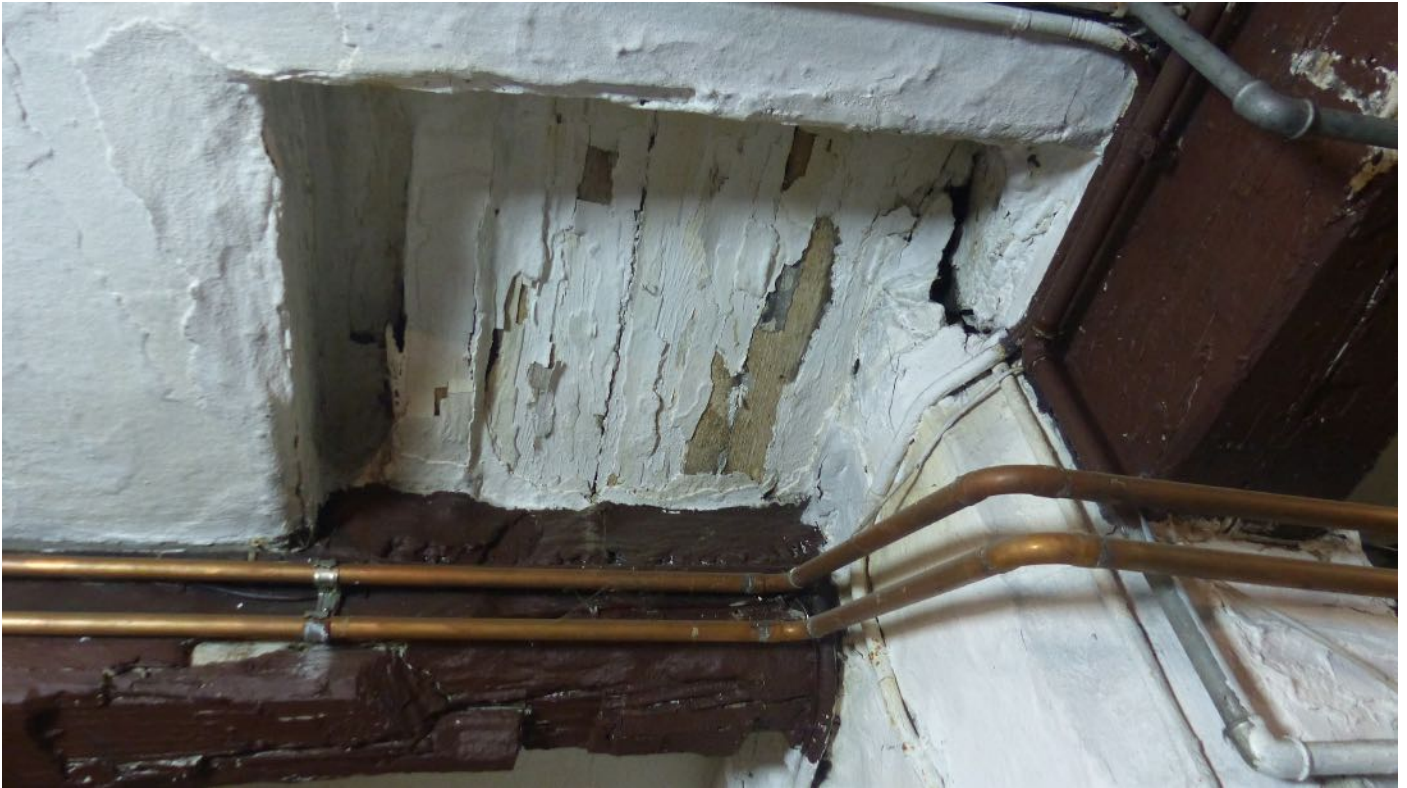
Befund D0.02_03: Verschlussener Deckendurchbruch
