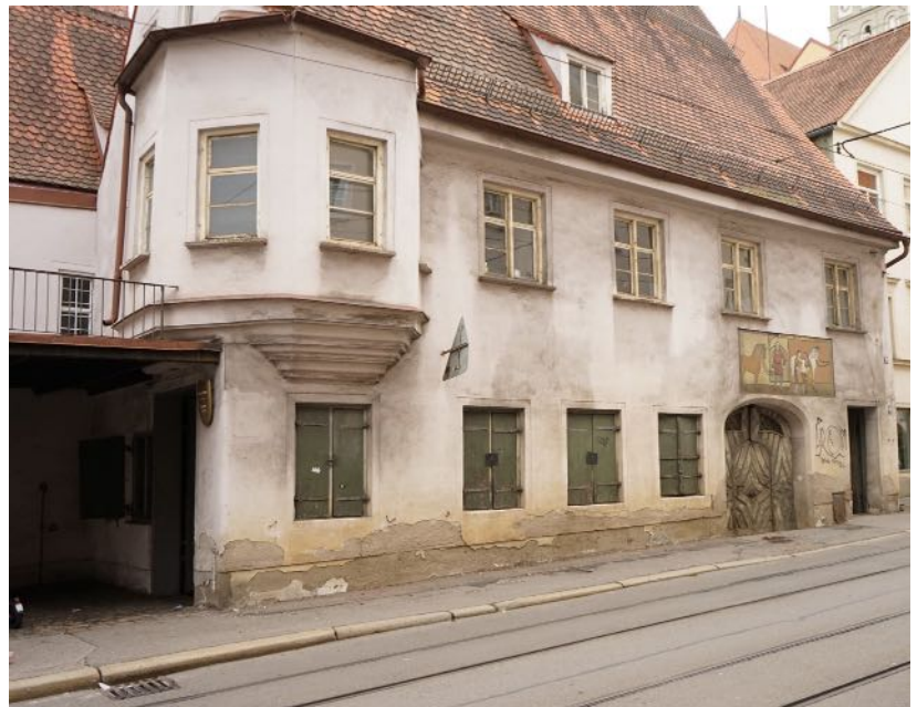
rechts: Aussenansicht Nordfassade, Sicht vom Milchberg
