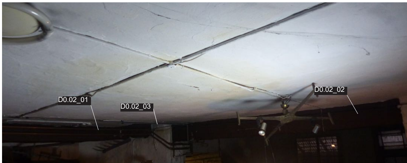
Blick von T0.01 / 0.02 auf Decke 0.02
