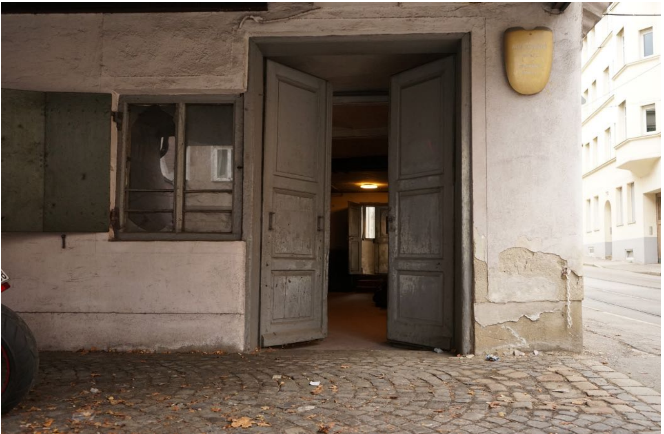
Blick von außen auf Türe mit Seitenfenster
