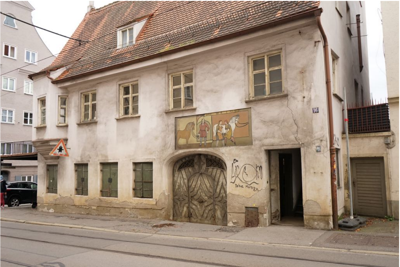
Aussenansicht, Blick von der gegenüberliegenden Straßenseite
