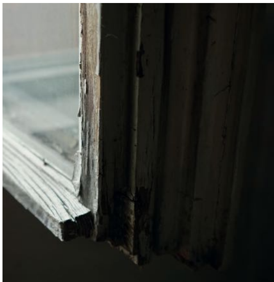
Detailaufnahme F 1.06 b, 2-flügeliges Verbundfenster
