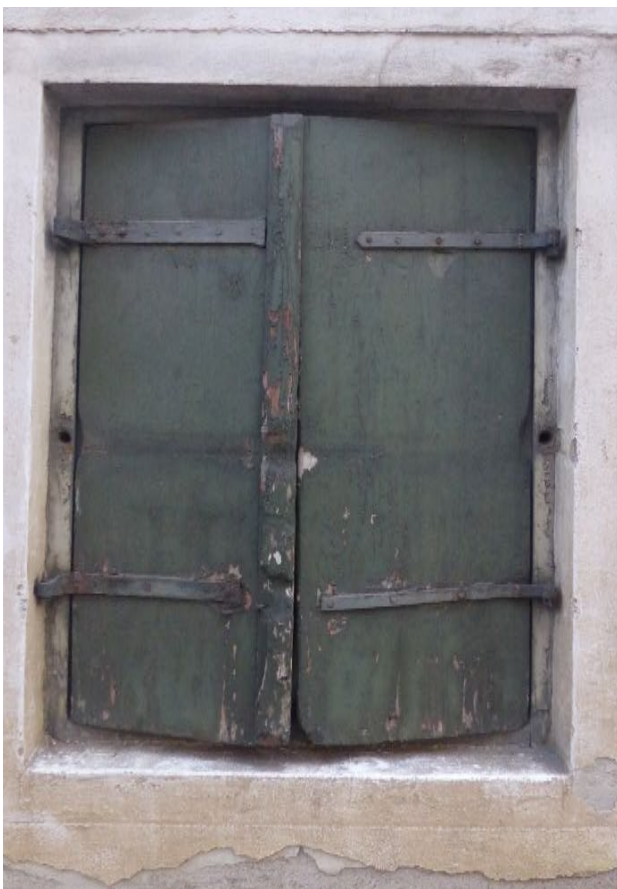
Fenster 0.02a / F1 außen
