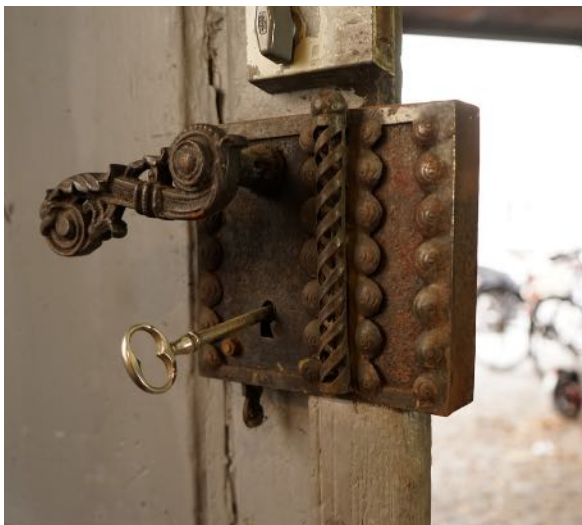
links : intaktes Kastenschloss
