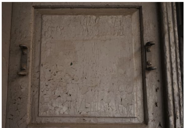
rechts : Detailaufnahme Halterungen an Türblatt ausen
