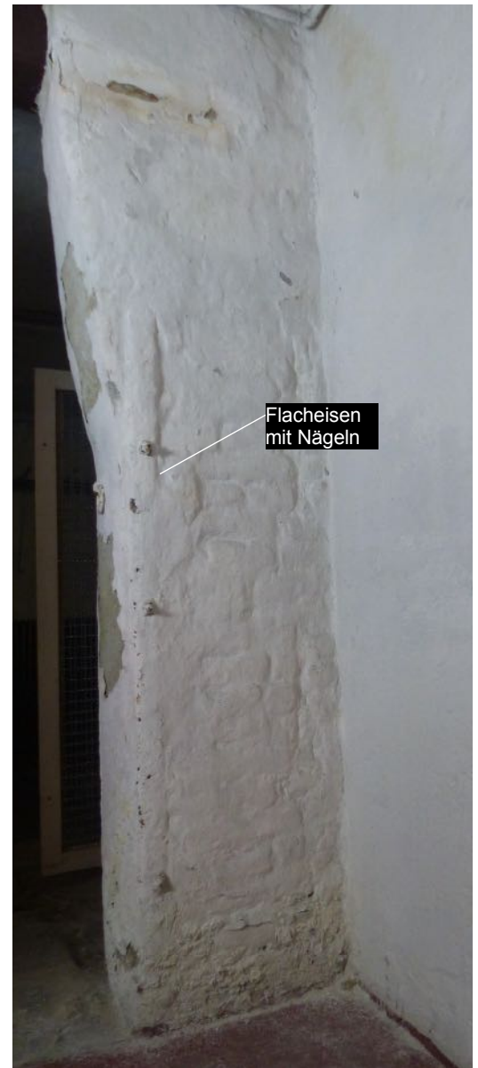
Befund 0.02h_02: Flacheisen mit Nägeln
