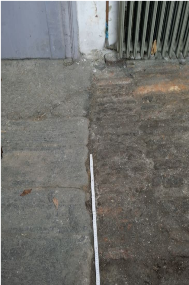
Boden 0.02 Dielen- und Ziegelboden
