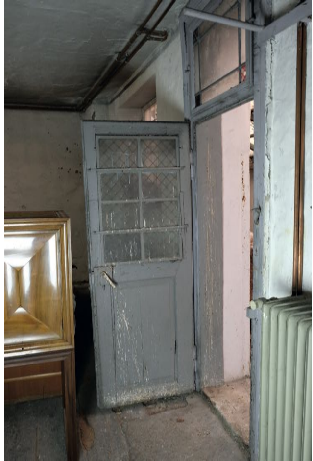
Blendrahmentür T 0.02e mit Oberlicht
