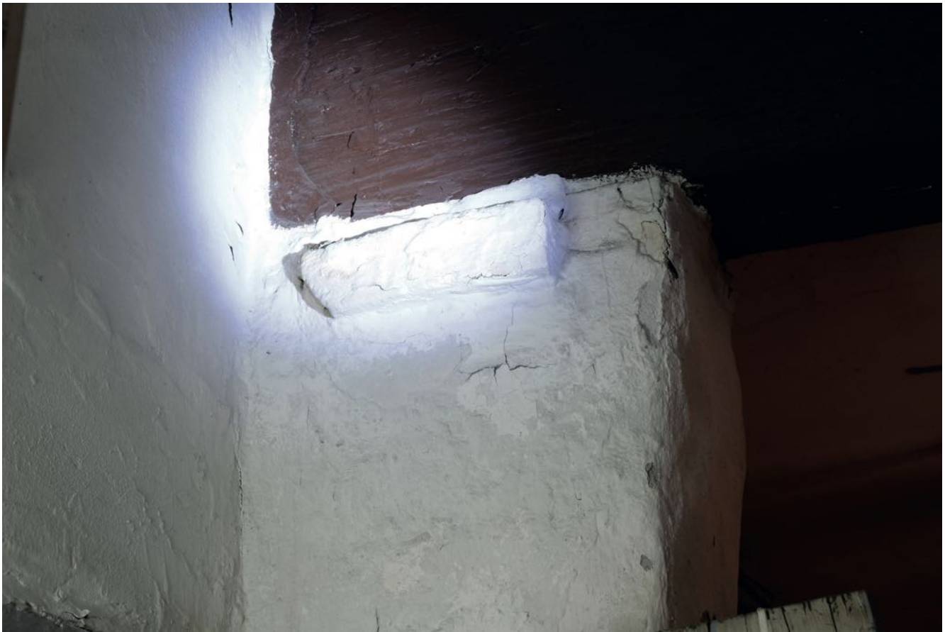
Wand 0.02g Unterzug mit Auflager
