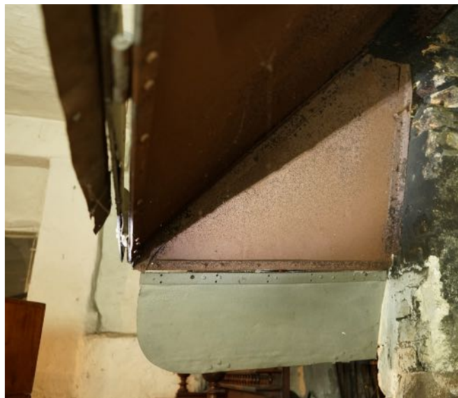
links: Detailaufnahme Rauchabzug rechts: Detailaufnahme Lochblech oberhalb der Esse
