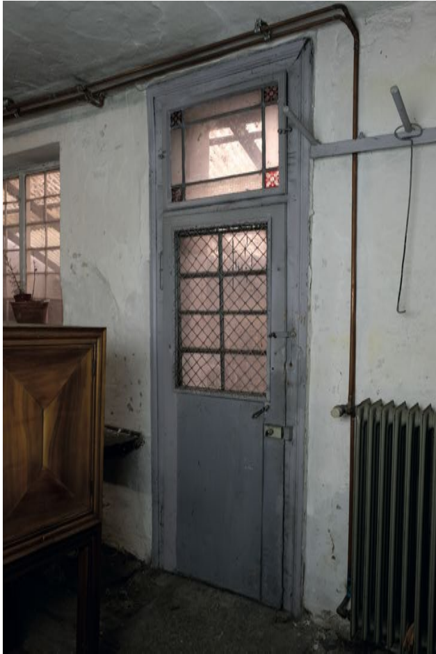
Blendrahmentür T 0.02e mit Oberlicht
