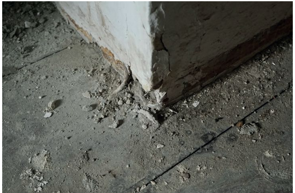
Detailaufnahme Ecke Wand 1.06 d und e, Befund 3
