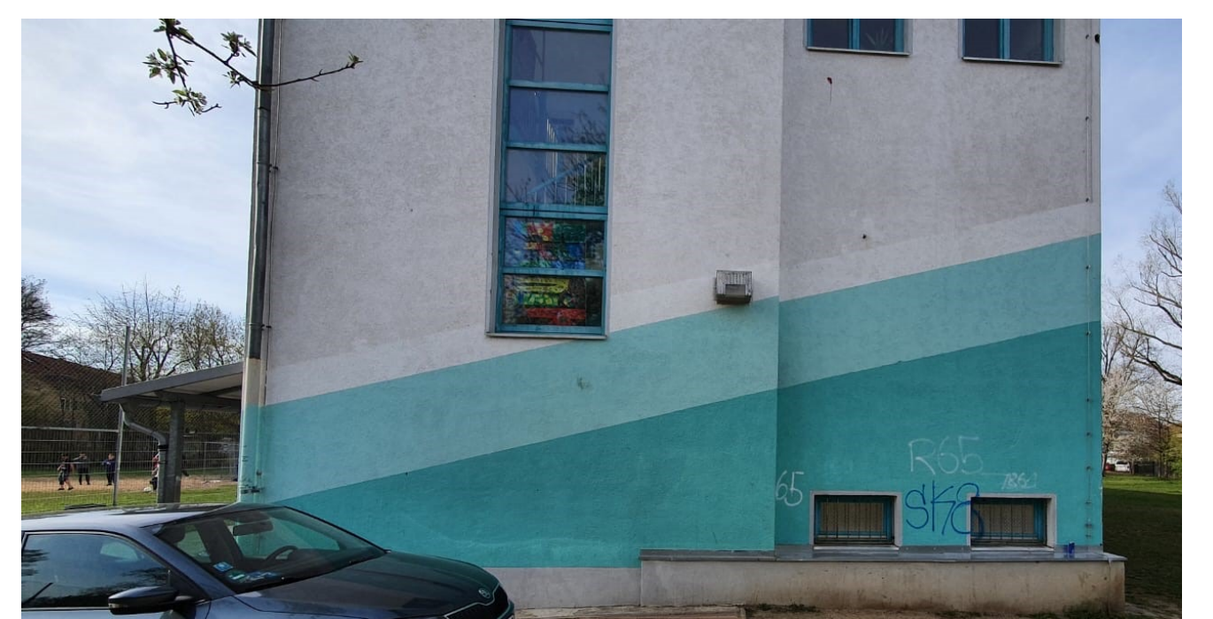
Die zu gestaltende Fassade am Jugendzentrum „fabrik“, Quelle: Nicolas Anzenhofer
