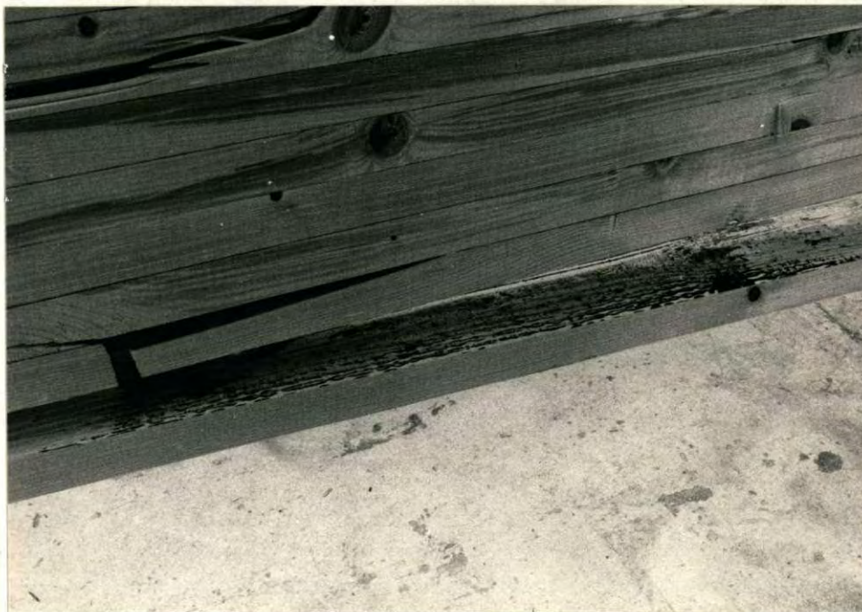
Bild 43: Abgeschälte, unterste Zuglamelle mit "schlechter" Leimfuge
