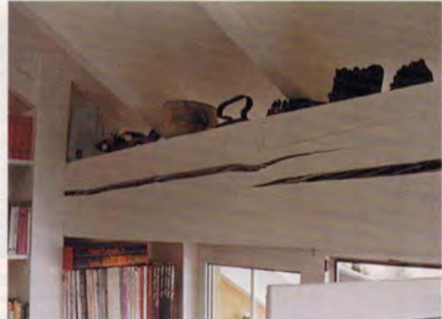
Bild 8: Großer Riss: optischer Mangel, aber keine Beeinträchtigung der Tragfähigkeit
