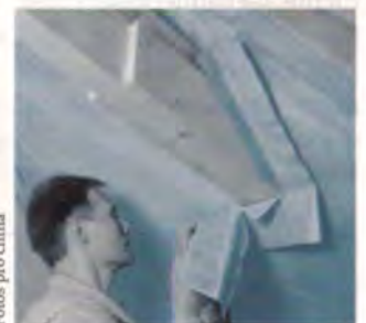
Bild 11: Luftdichte Balkendurchdringung unter Verwendung von Manschetten
