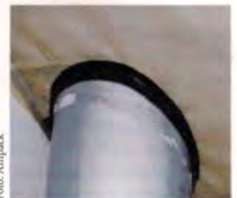
Bild 10: Abdichtung einer Rohrdurchdringung mit einem Butylkautschuk-Dichtungsband
