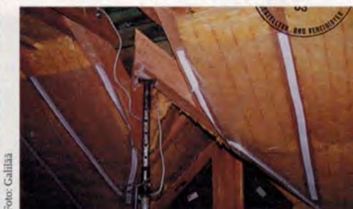
Bild 5: Stabdübelanschluss mit fehlenden Stabdübeln
