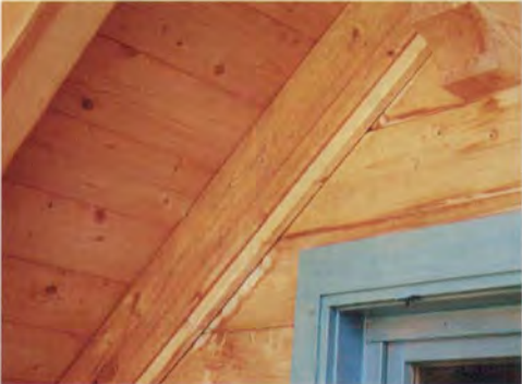
Bild 7: Tauwasserbildung auf der Außenseite infolge Luftströmung (Konvektion) durch undichte Fugen
