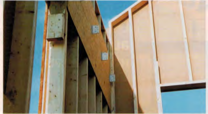
Bild 2: Vormontierte Stahlformteile zum Anschluss der Deckenbalken
