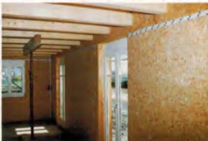
Bilder 3 und 4: Durchgehende offene Fuge in der Wandbeplankung
