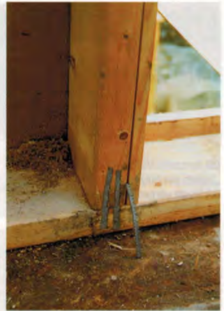
Bild 5: Wandverankerung mit dünnen gezahnten Blechen.
