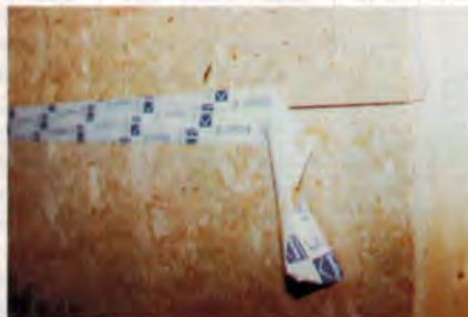
Bilder 3 und 4: Durchgehende offene Fuge in der Wandbeplankung
