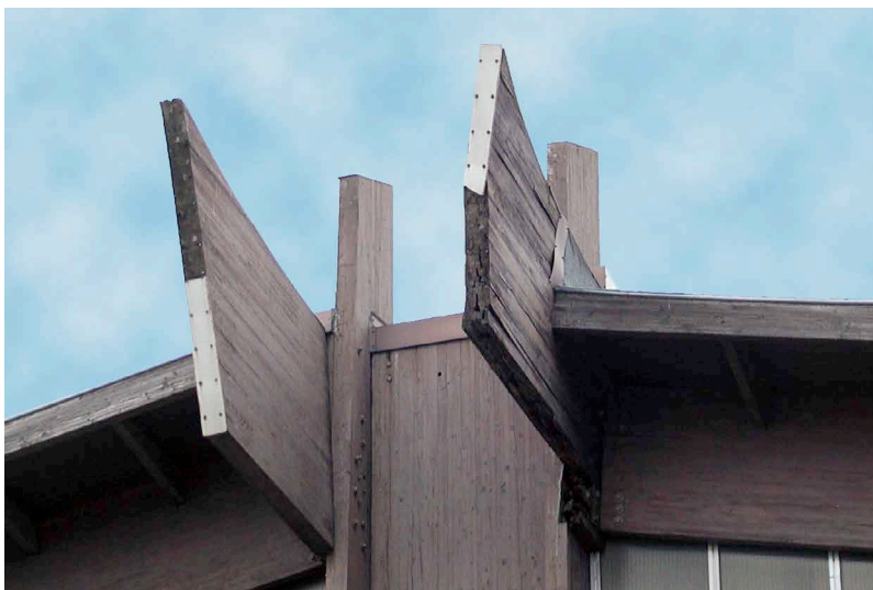
Das darf nicht sein: Holz in ungeschützter Außenanwendung
