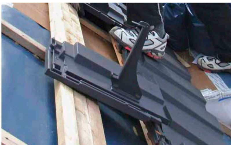
◀ Bild 1: Typischer Dachziegel mit Schneefanghaken
