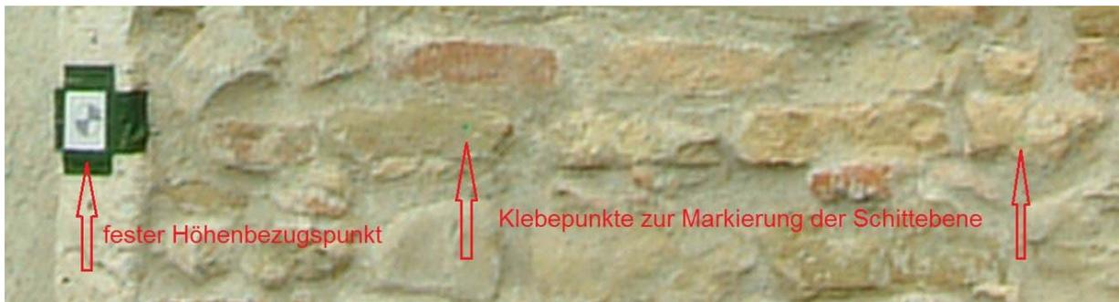
Bild 3: Beispiel für die Höhenmarkierung am Mauerwerk
